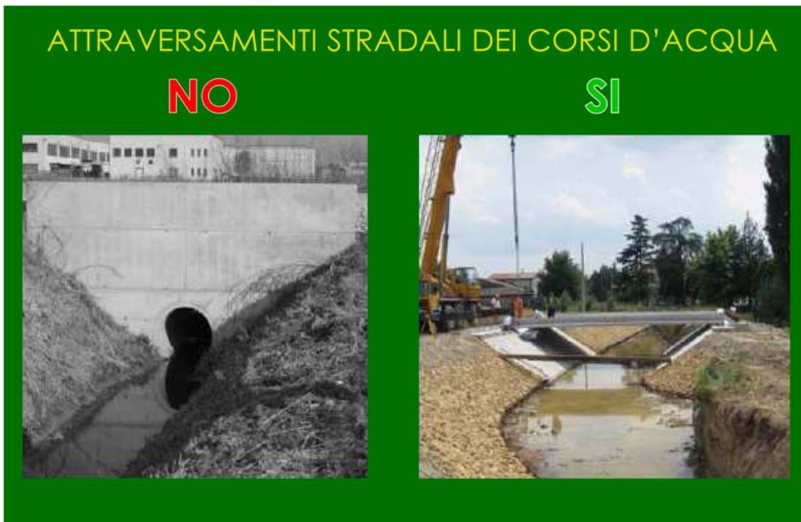
Figura 6.3 - Schema per la realizzazione degli attraversamenti dei corsi d'acqua: a sinistra la pratica sconsigliata di usare tubazioni di diametro ridotto, a destra la corretta realizzazione di un ponticello.
